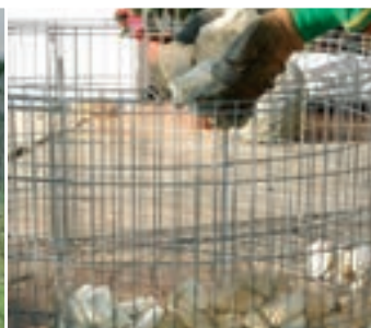
6. Mit Steinen befüllen
